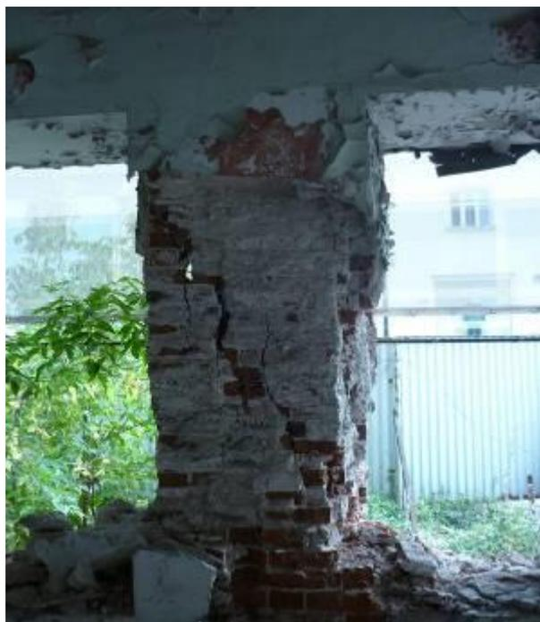
Рис. 2. Наклонная трещина (25 мм)
