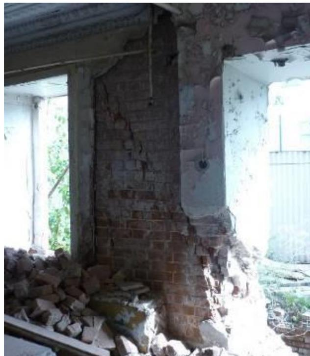
Рис. 5. Наклонная трещина (20 мм)
