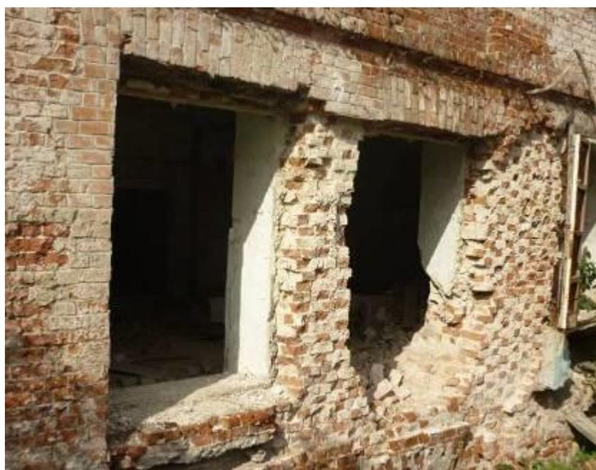
Рис. 3. Разрушение кирпича, раствора
