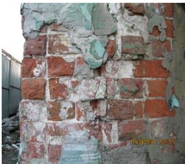
Рис. 1. Вертикальная трещина (4 мм)
