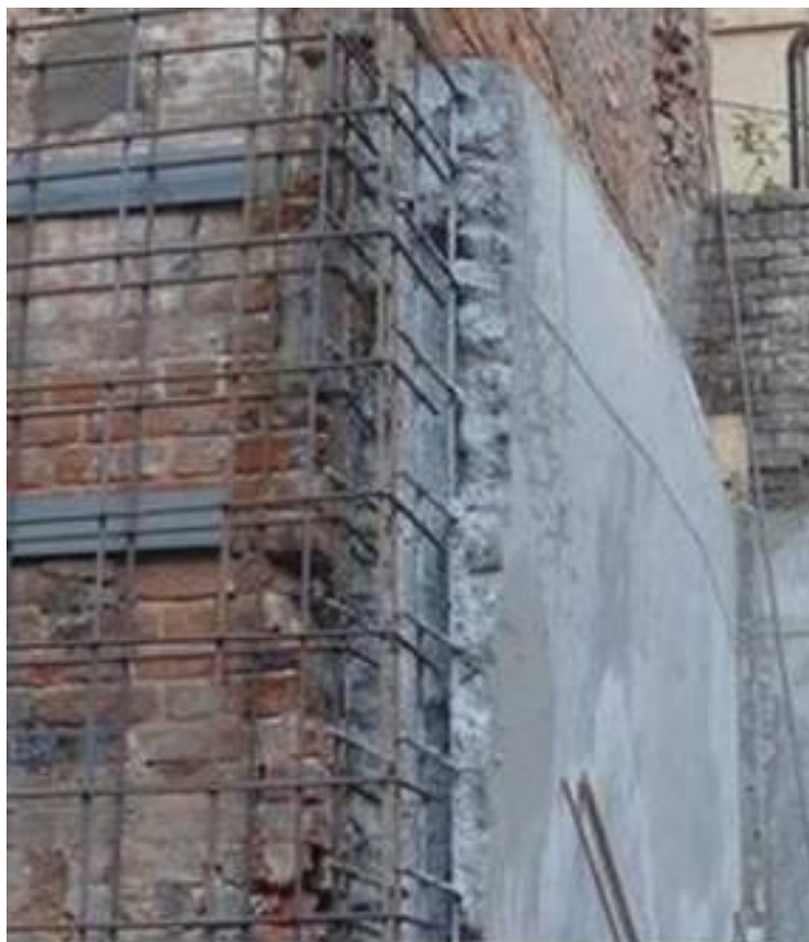
Рис. 8. Усиление каменной стены железобетонной обоймой
