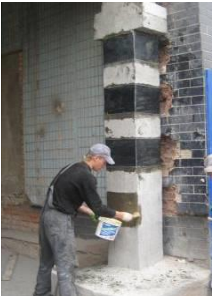
Рис. 7. Усиление железобетонной колонны обоймой из углеволокна
