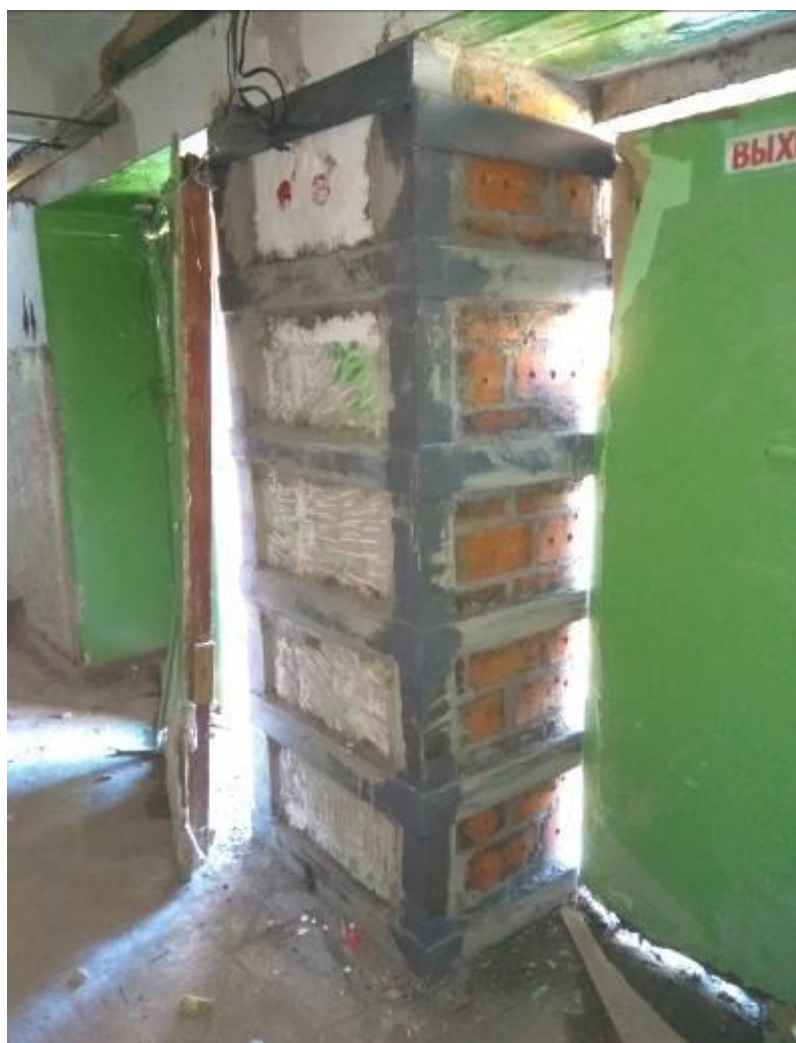
Рис.6. Усиление каменного простенка стальной обоймой
