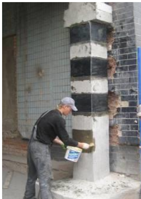
Рис. 7. Обойма из углеволокна
