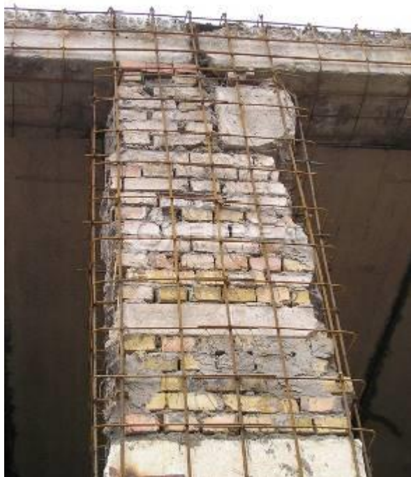
Рис. 8. Каркас железобетонной обоймы
