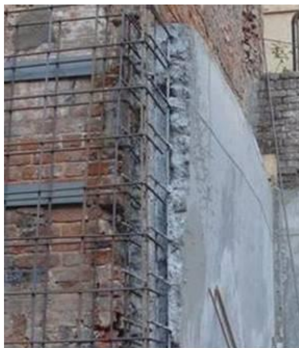
Рис. 9. Железобетонная обойма
