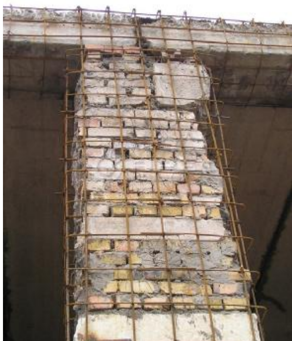
Рис. 8. Каркас железобетонной обоймы
