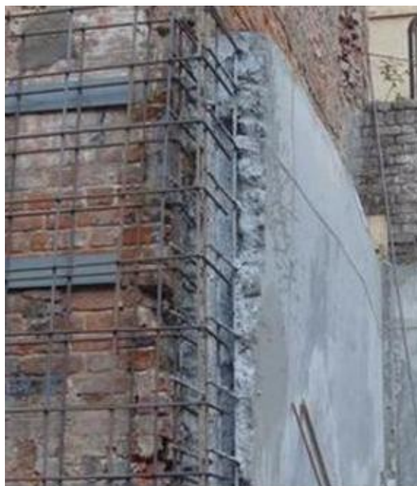
Рис. 9. Железобетонная обойма
