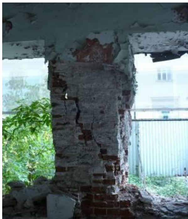
Рис. 2. Наклонная трещина (25 мм)
