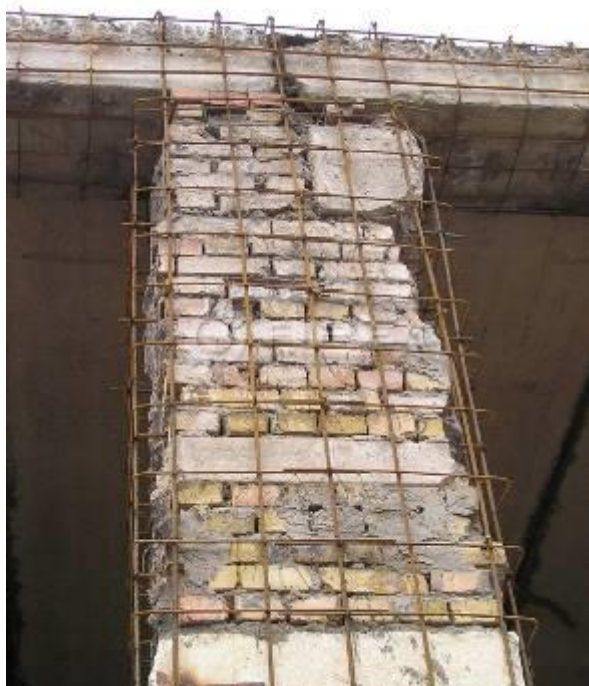
Рис. 8. Каркас железобетонной обоймы
