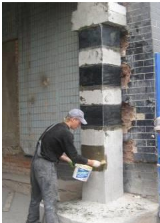
Рис. 7. Обойма из углеволокна
