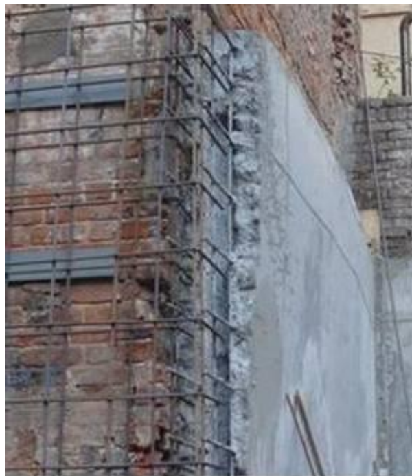
Рис. 9. Железобетонная обойма
