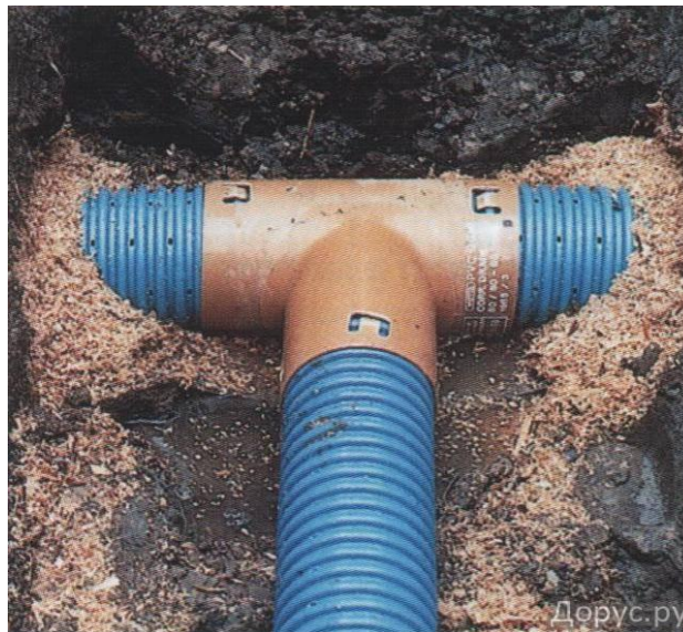
Рис. 1.5. Муфтовое соединение дрен из полиэтиленовой трубы «Перфокор»
