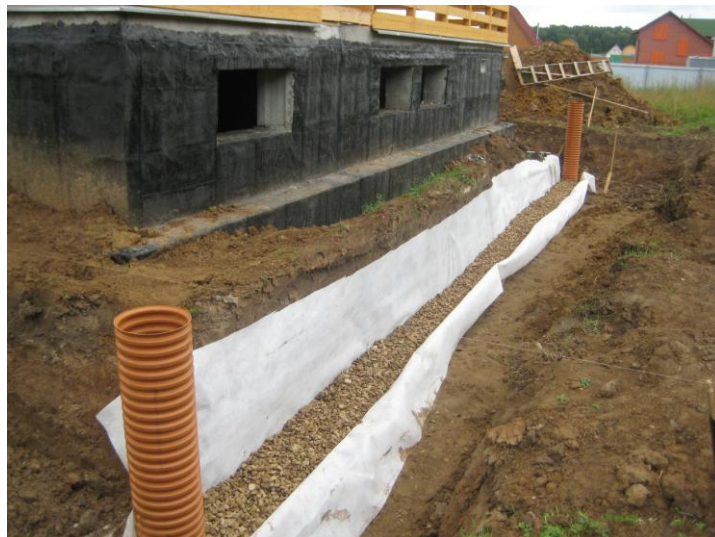
Рис. 1.2. Схема элементов дренажа (на примере кольцевого дренажа) – сверху. Устройство в специальных траншеях дрены со смотровыми колодцами – внизу
