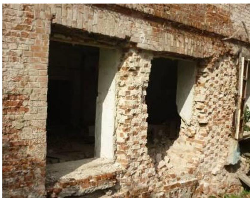
Рис. 3. Разрушение кирпича, раствора
