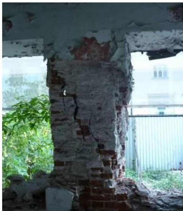
Рис. 2. Наклонная трещина (25 мм)
