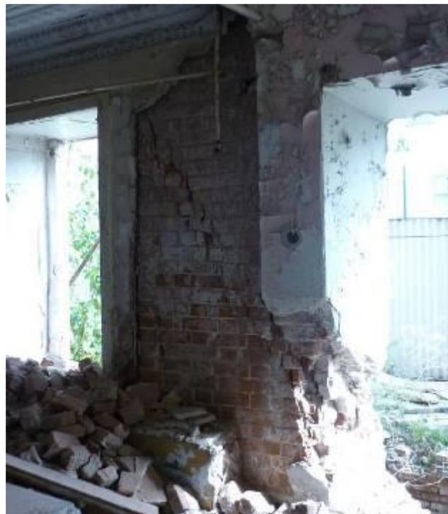
Рис. 5. Наклонная трещина (20 мм)
