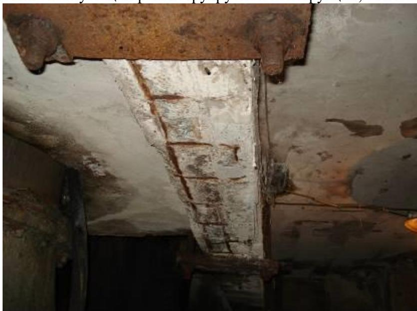
Рис.1. Фотография общего поврежденной конструкции
