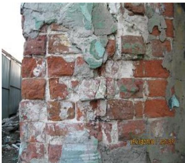
Рис. 1. Вертикальная трещина (4 мм)
