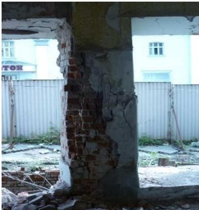
Рис. 4. Вертикальные трещины (15мм)
