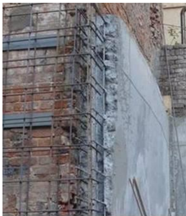
Рис. 9. Железобетонная обойма
