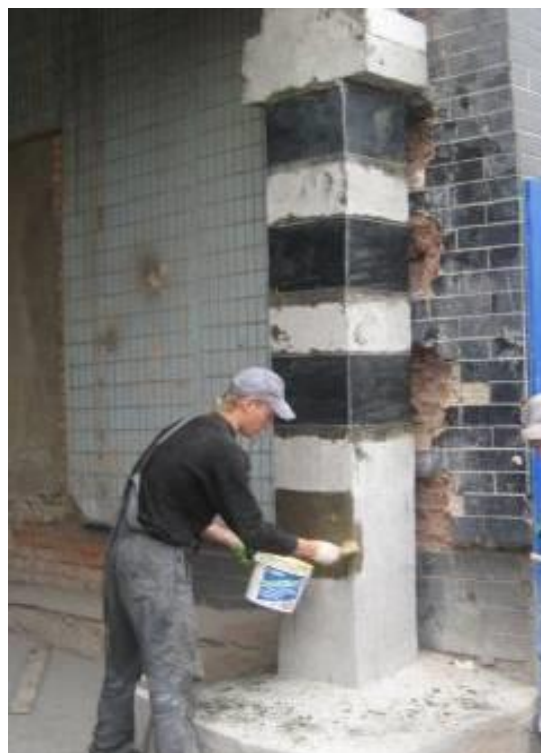
Рис. 7. Обойма из углеволокна
