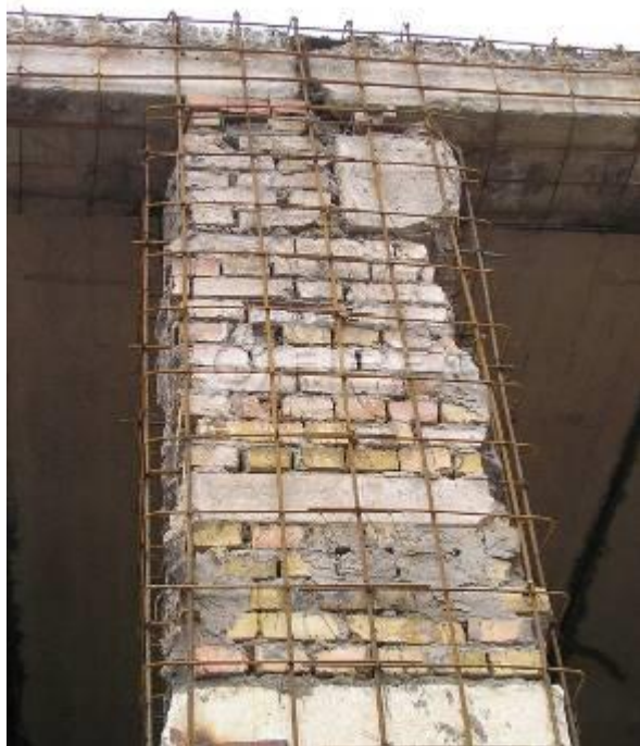
Рис. 8. Каркас железобетонной обоймы
