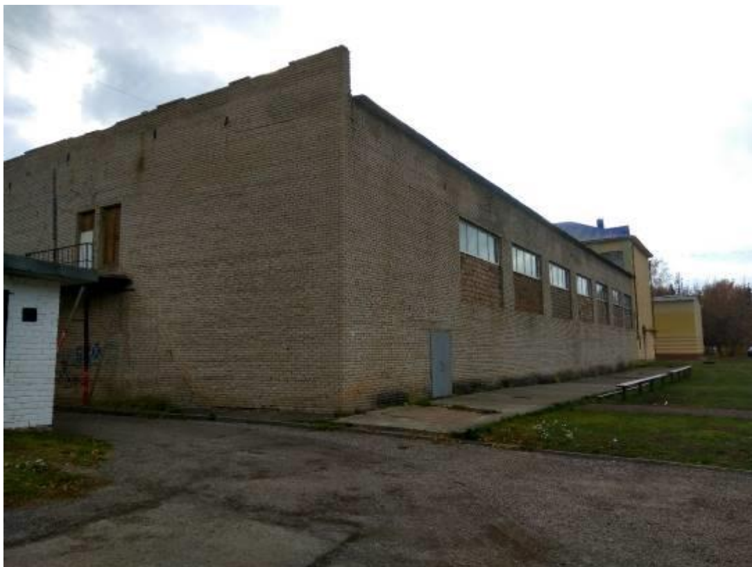
Рис.1. Фотография общего вида обследуемого здания (пример)
