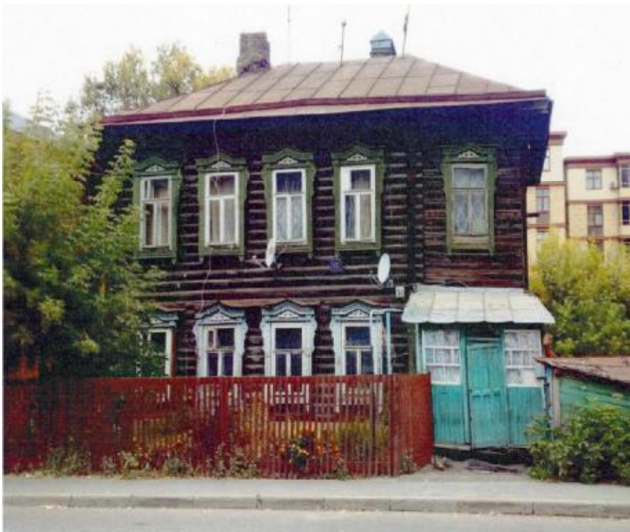
Рис.1. Фотография общего вида здания
