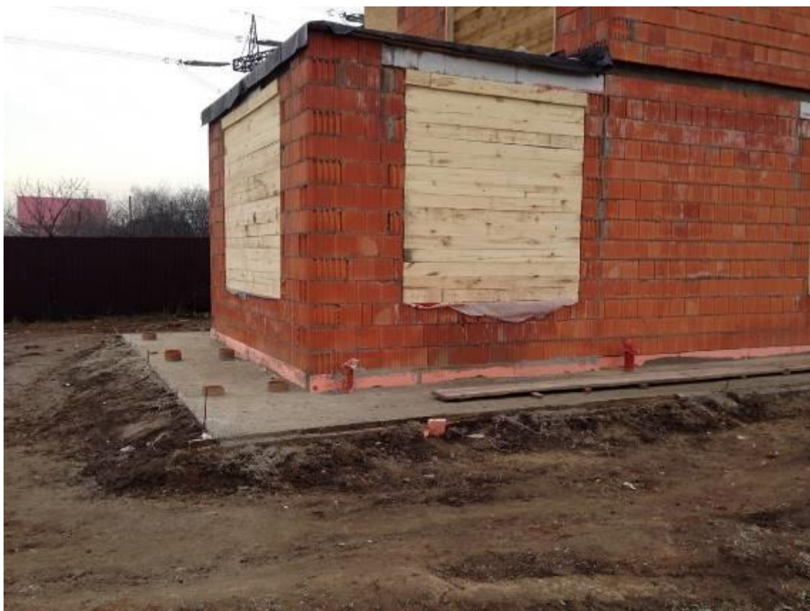
Рис. 2 Установка деревянных щитов на окнах первого этажа
