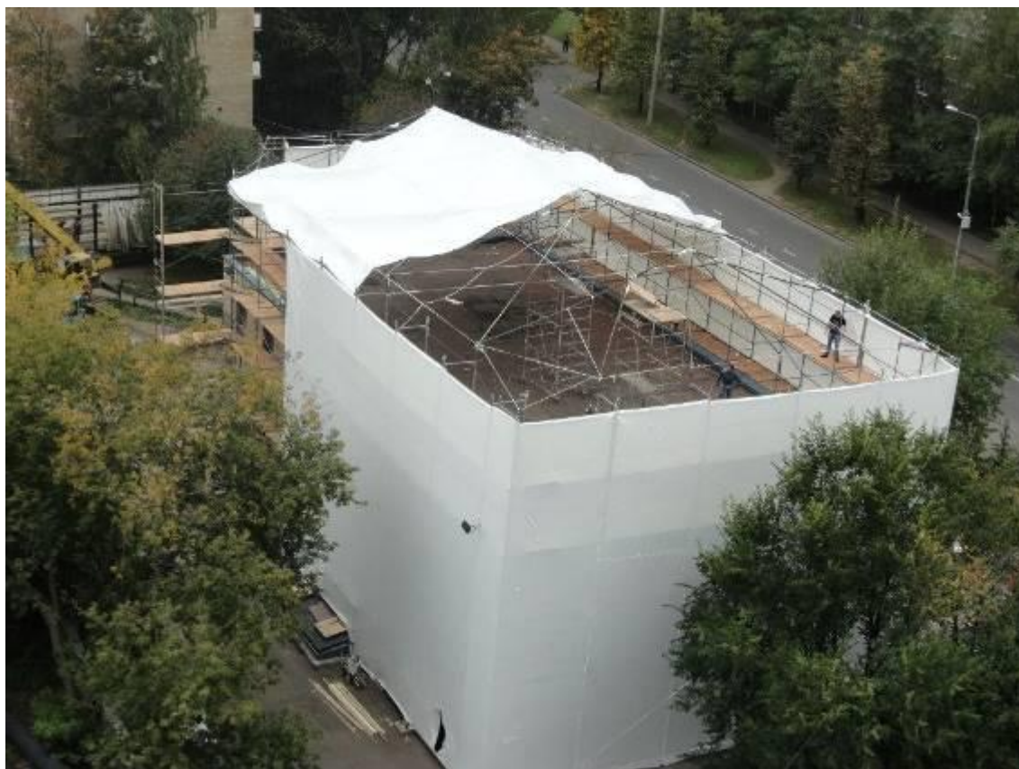
Рис.1 Подготовка ограждающих конструкций и монолитной плиты покрытия к консервации
