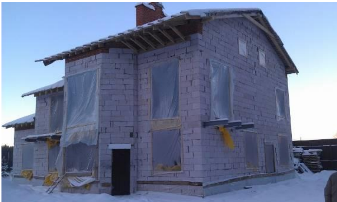
Рис. 3 Закрытие проемов пленкой для предотвращения попадания влаги
