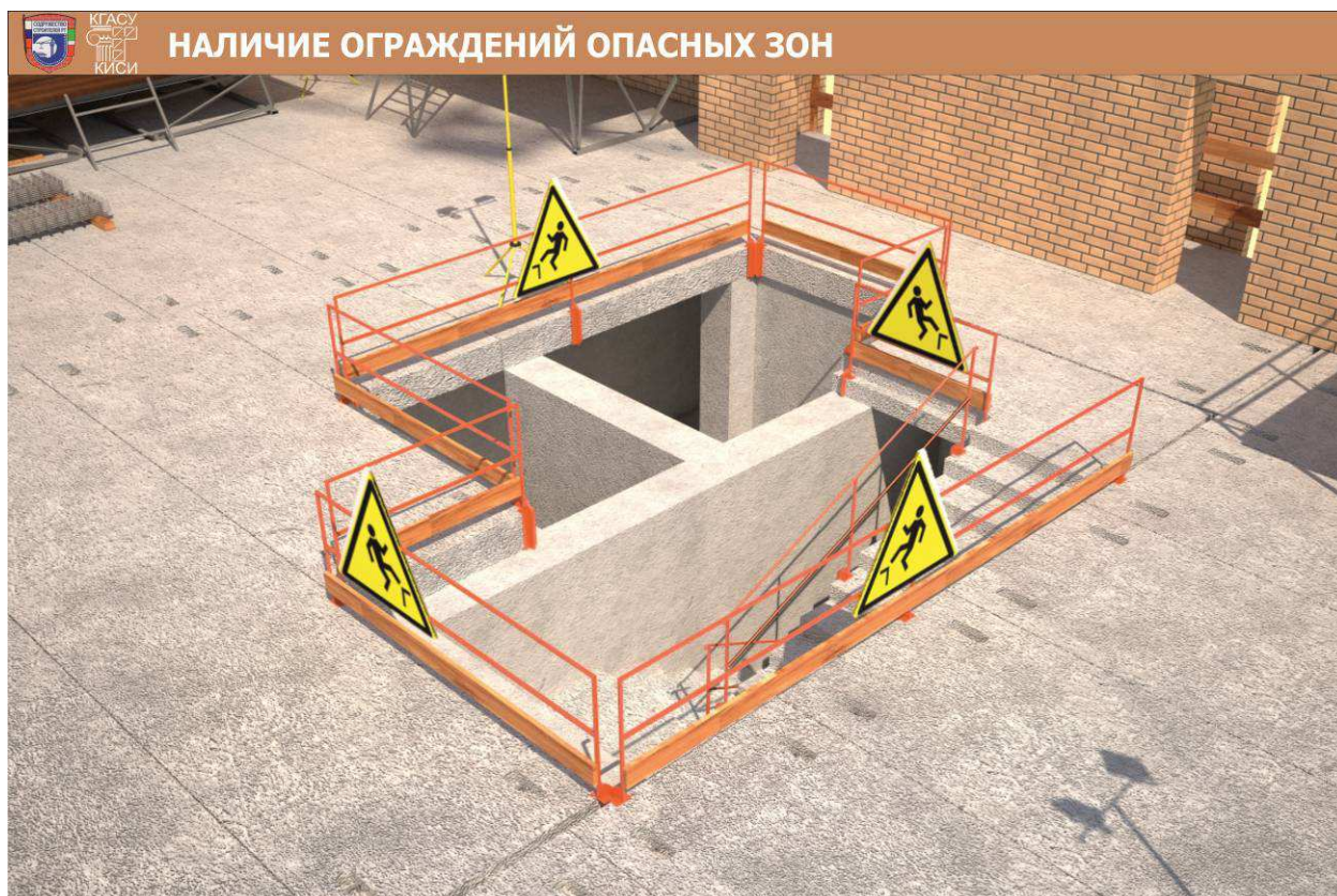
Рис.20. Устройство защитных ограждений для предотвращения падения с высоты
