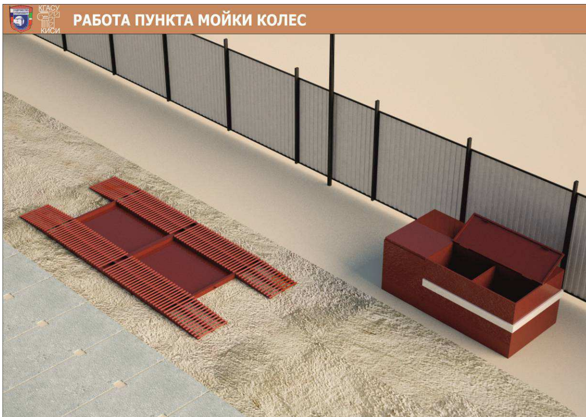
Рис.5. Устройство пункта мойки колес при выезде со строительной площадки
