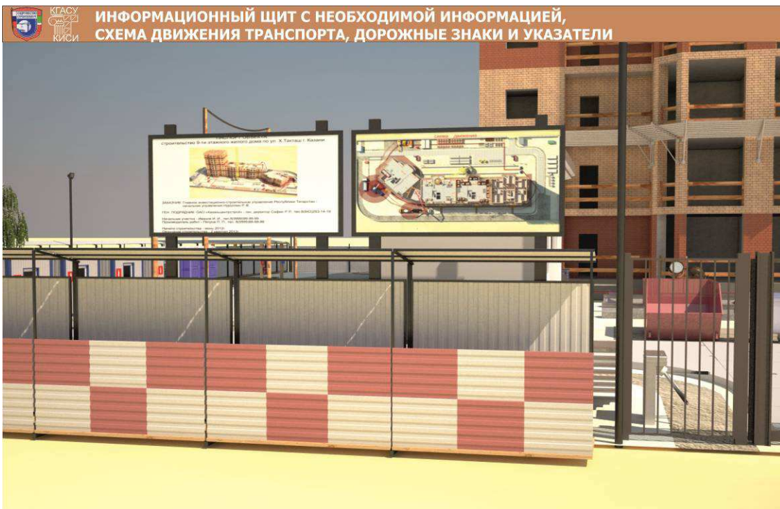
Рис.2. Информационное обеспечение входной группы и устройство ограждения строительной площадки со стороны улицы
