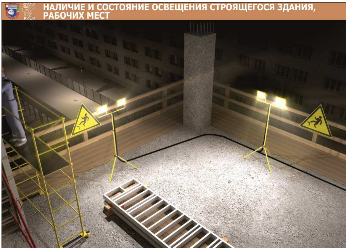
Рис.7. Организация освещения на рабочем месте
