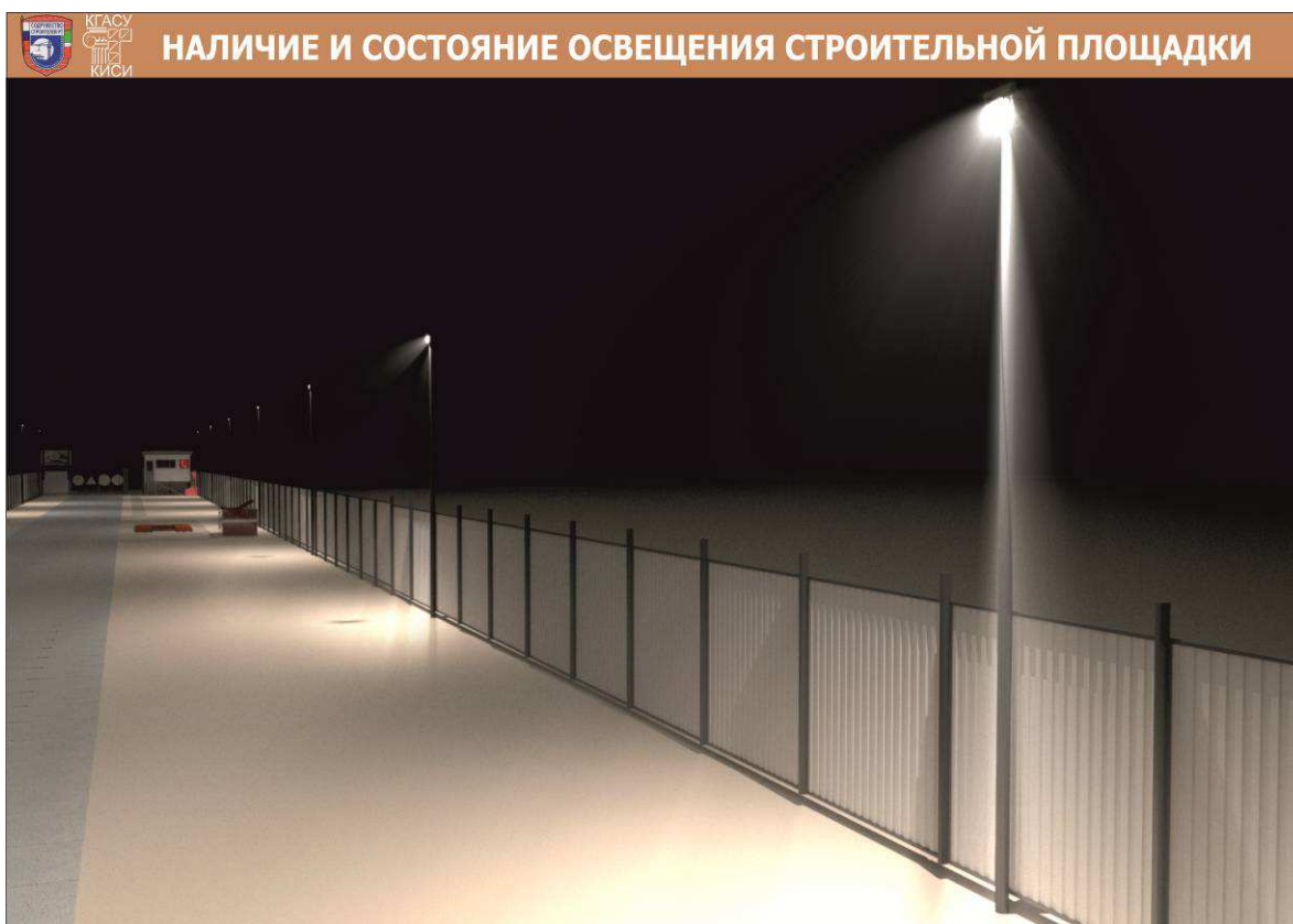
Рис.6. Охранное освещение строительной площадки
