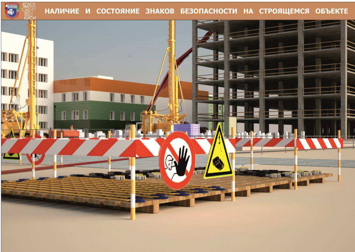
Рис. 9. Устройство сигнального ограждения и знаков безопасности зоны складирования
