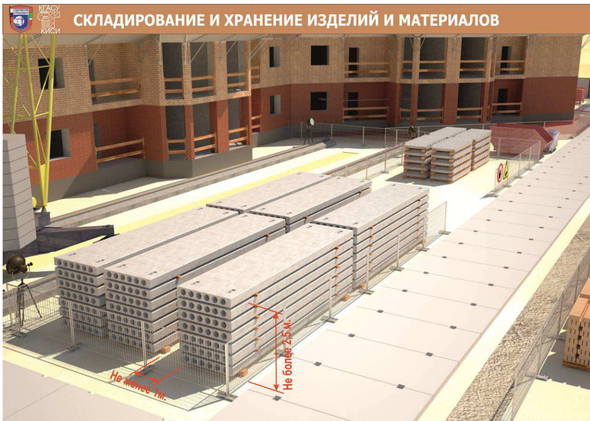
Рис.13. Складирование железобетонных плит перекрытия
