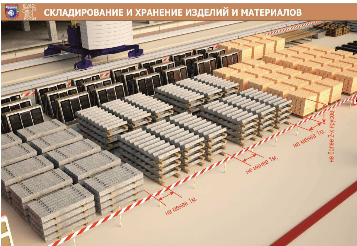
Рис.10. Организация складирования строительных материалов на стройплощадке
