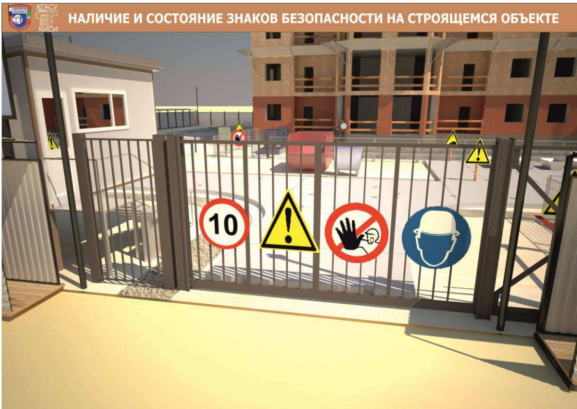
Рис.3. Размещение знаков безопасности на входной группе строительной площадки
